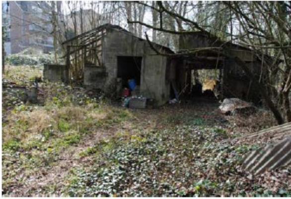
Figure 9 – Serre et abri dans le fond du jardin arrière.
